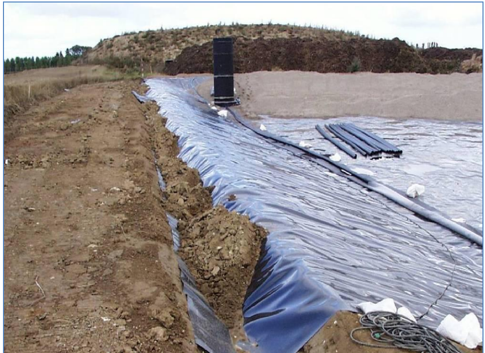
Պատկեր 30 Թափոնների տեղավորման բաժանմունքի կառուցում, ստորին կալային շերտով, Բարձր խտությամբ պոլիէթիլենի միջադիրով, և ֆիլտրատի հավաքման հարսով՝ աղբավայրի բաժանմունքի ամենացածր կետում
